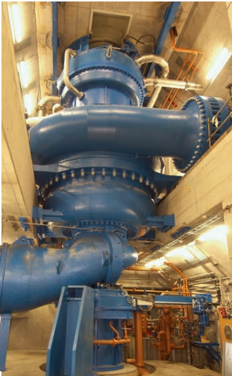
Abb. 6: Pumpe und Wandler: Die Gesamthöhe des Maschinensatzes beträgt rund 38 Meter.
