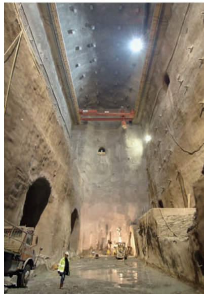
Abb. 3: Die riesige Kavernenkrafthaus ist 88 Meter lang und über 60 Meter hoch.
