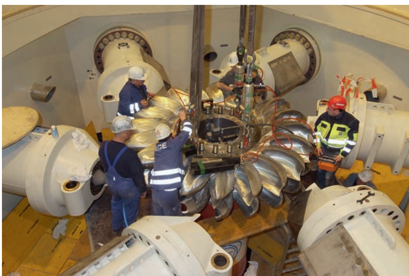
Abb. 5: Im Kopswerk II gibt es insgesamt drei sechsdüsige Pelton-turbinen.
